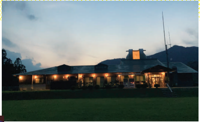
天井部の丸い部分が天文台。
